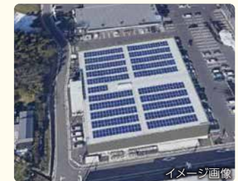
ひまり大庭店の屋上へ太陽光発電設備を設置
