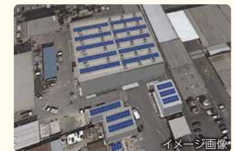
アースサポート(株)本社の屋上へ太陽光発電設備を設置
