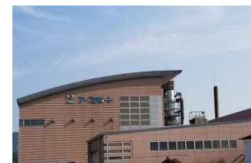
更新を予定している選別棟
