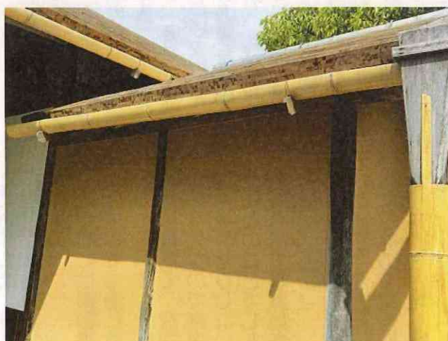
竹製の雨樋（桂離宮）
