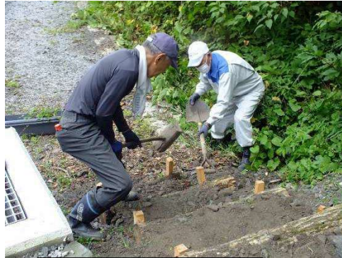
入口法面の階段作り
